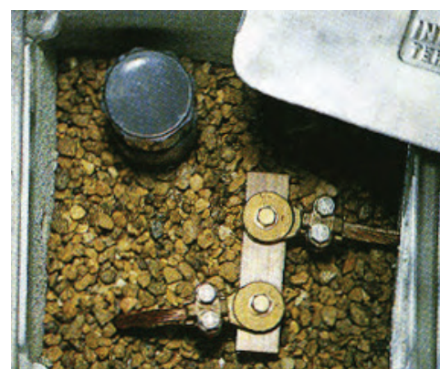
Fig. 13 – Secção transversal de uma ligação à terra.
